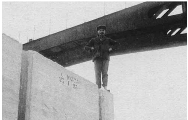
Ayub su uno dei blocchi di cemento utilizzati per costruire le dighe frangiflutti.
